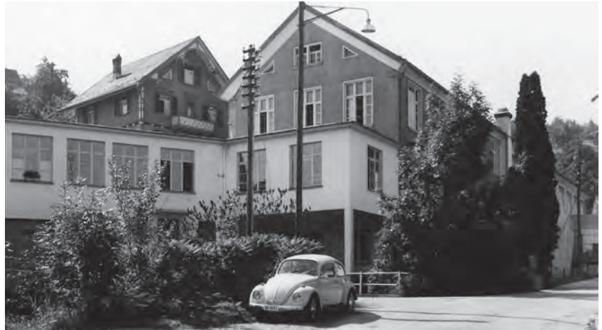
Fabrikgebäude der Zwirneri Tobelmühle Lutzenberg, an der Gemeindegrenze zu Thal, um 1970
