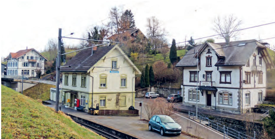
Post Wienacht-Tobel von 1905 bis 1967: «Pöstli» (links), «Bahnhöfli» (rechts) und Bahnhof Wienacht-Tobel (Mitte)
