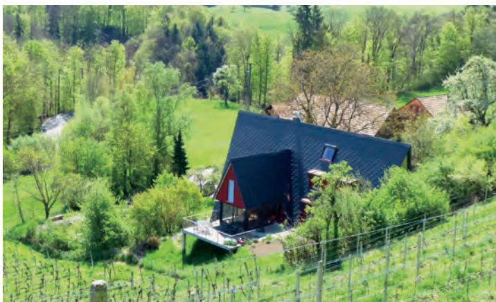
Nach der Renovation (Ansicht von Norden)
