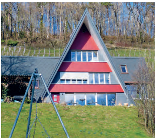
Nach der Renovation (Ansicht von Süden)
