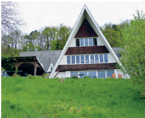
Vor der Renovation (Ansicht von Süden)
